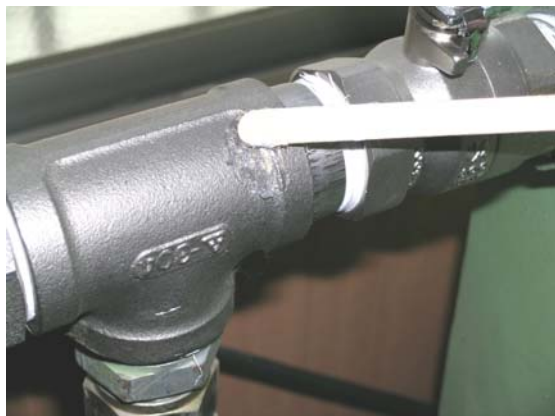
真空系統填縫、修補
